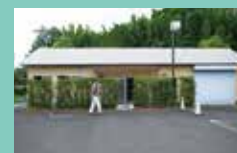
14 大里会館詰所
